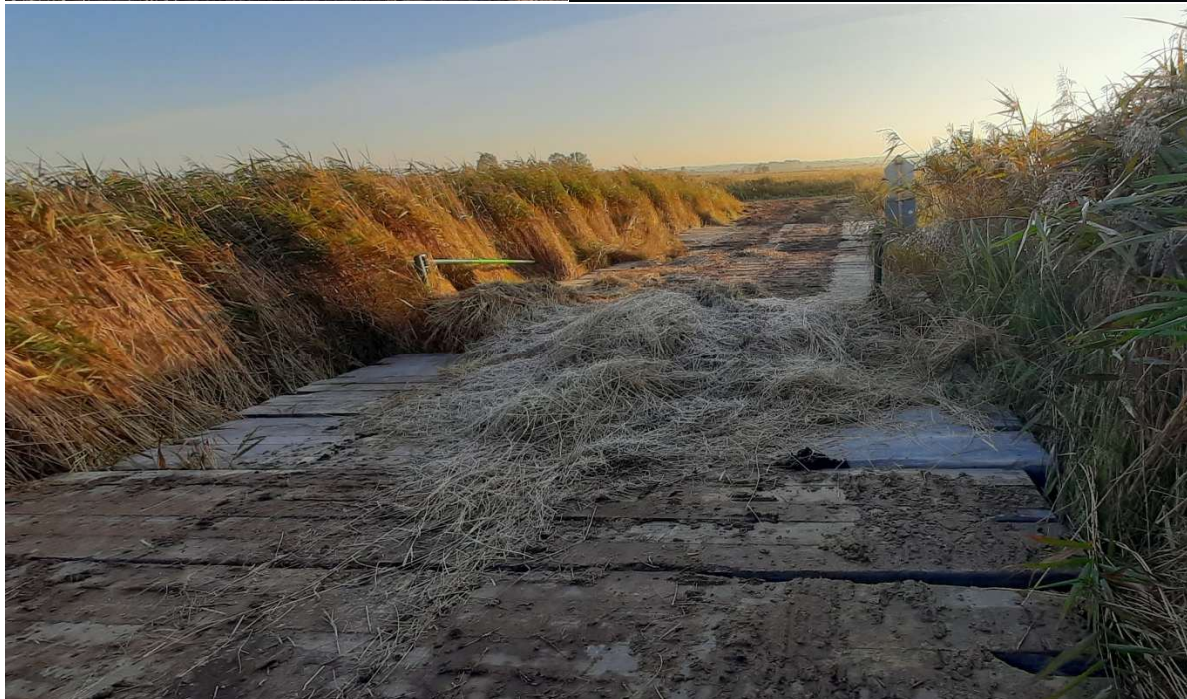
Abb. 3: Aufbau der Behelfsbrücke aus Baggermatten, Notfallmaßnahme Zuwegung Ehemaliger Fuh-lensee, Foto: A. Miehe; P. Ruge
